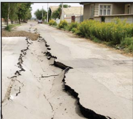
Участък от улица "Кирил и Методий" в село Магара пропадна след подмяна на канализацията. Асфалтът е потънал на дълбочина повече от половин метър в участък с дължина 100 метра
