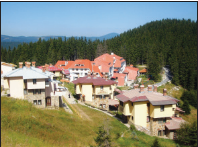
И Райковските ливади са бетонирани
