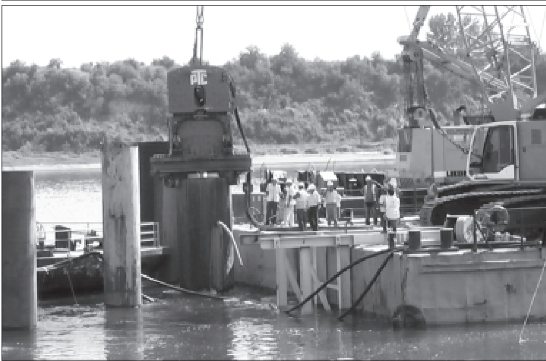
В средата на реката е забита първата опорна колона на Дунав мост 2 при Вудин-Калафат
