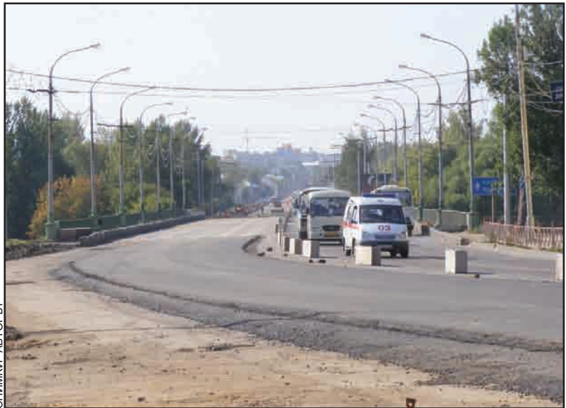
Ремонти и строени. Това е Ярославъл, но гледката е такава навсякъде
