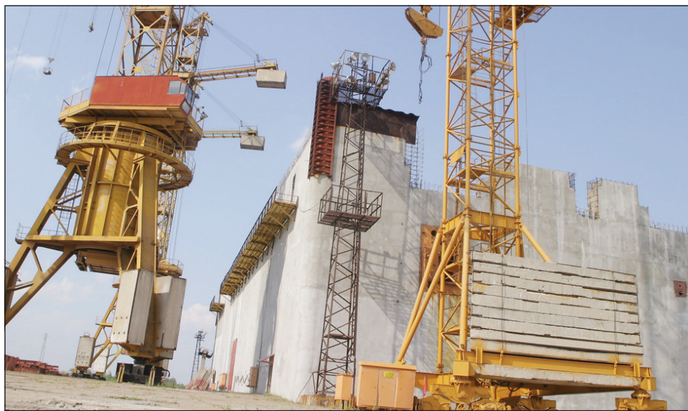
„Белене“ със стария корпус на реактора. Той вече е разрушен, както бе планирано. Сега умират и надеждите да имаме нова ядрена мощност
