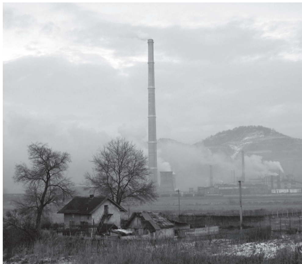
Фабрика в Централна Румъния. Производствените предприятия страдат от липса на модерно оборудване и това води до значително екологично замърсяване
