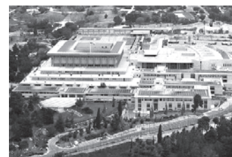
Израелският Кнесет може да претендира, че е най-екологично чистият парламент на света. На покрива на сградата започна монтажът на 1406 фотоволтаичски батерии с обща площ 4,65 хиляди квадратни метра
