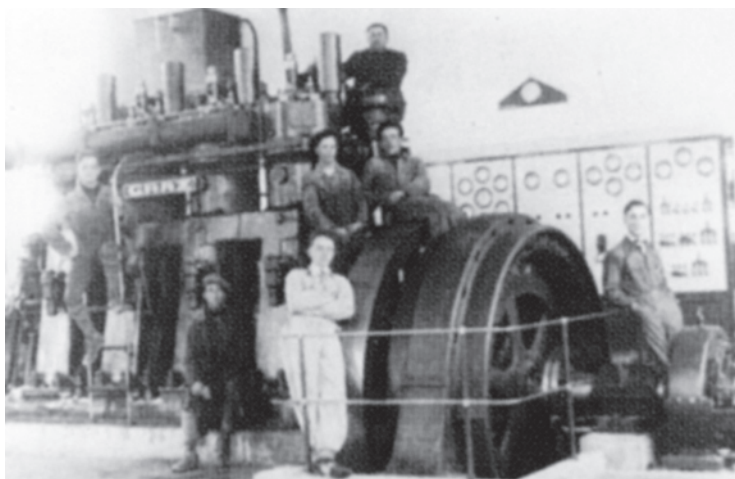
Дизеловият генератор на Електрическа кооперация "Х. Димитър" в Сливен - 1928 г.
