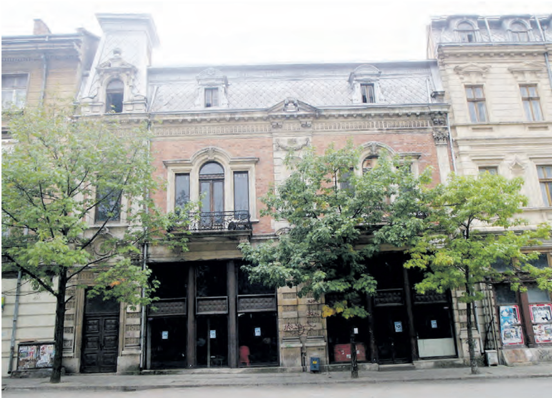
Дом „Канети“ на ул. „Славянска“ в Русе
